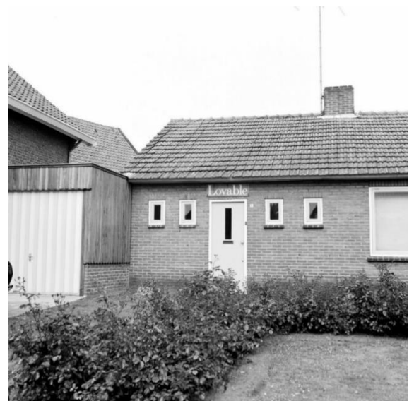
Het atelier Bovenstraat 5
